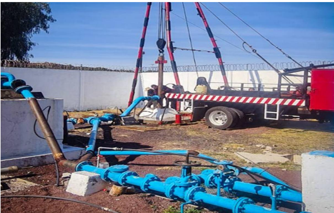
22. Mantenimiento de pozo
