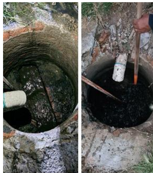
24 Desazolve de drenaje
