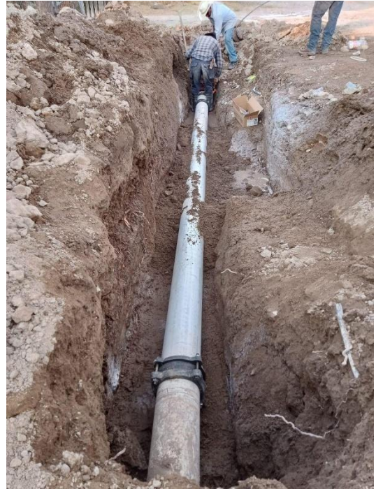
23 Mantenimiento de tramo de red de agua potable.
